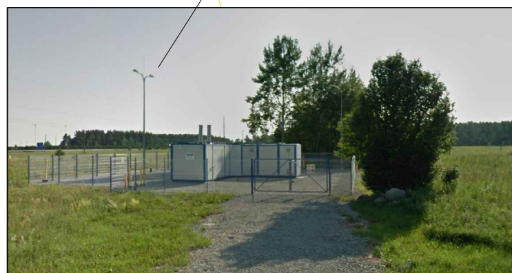
Vaade 1: 22116 Gaasijaotus-, gaasimööte- ja gaasireguleerijaam arvestusrõhuga kuni 16 bar. Asub planeeringuala sees paiknevatel tootismaa sihtotstarbega katastriüksustel.
